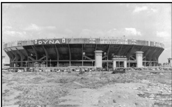
Construcción de la Monumental Plaza de Toros de México 1944
